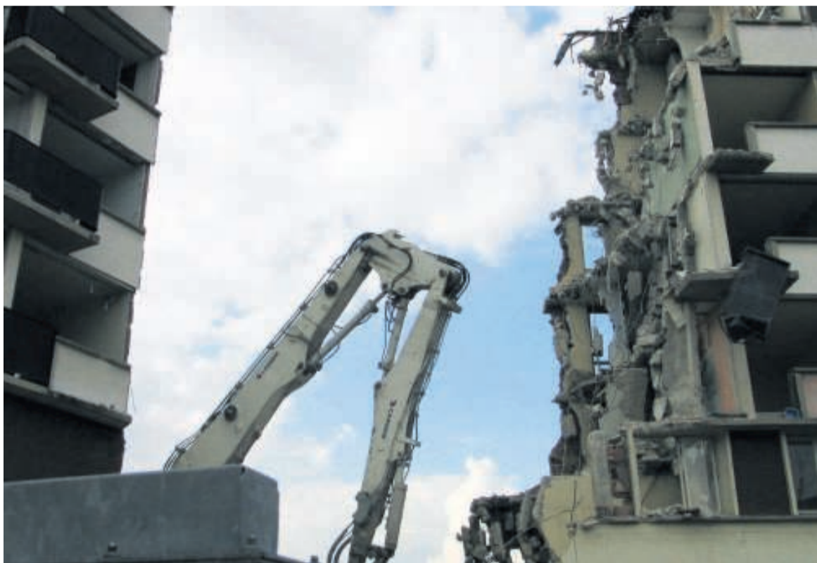
ANTONY, HIER. La démolition de la résidence universitaire d'Antony (RUA), l'une des plus importantes d'Europe, prendra fin d'ici à deux mois. Selon les défenseurs de la RUA, ces travaux cachent une opération immobilière. (L.P./I.C.)
