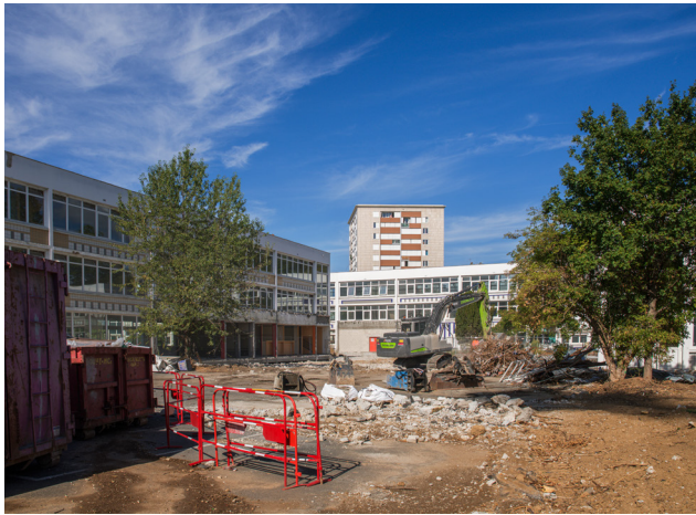
Travaux en cours au groupe scolaire Henri-Wallon
