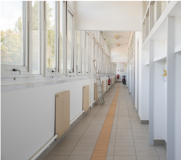
Travaux de peinture à l'école Diderot A
